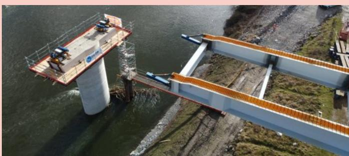
Fin janvier 2022, plusieurs convois exceptionnels acheminent sur le site des poutres métalliques de 15 tonnes destinées à être assemblées pour former la charpente de l'ouvrage. Une imposante charpente métallique, poussée progressivement au-dessus de la rivière, depuis la rive gauche, et qui vient se poser sur les différents appuis. Trois « lancements » sont nécessaires pour faire passer l'intégralité de la charpente et constituer ainsi l'ossature du deuxième pont de Moulins.
